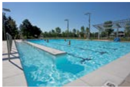
Desinfeccion y Descloraminacion en piscinas y spas colectivos.
